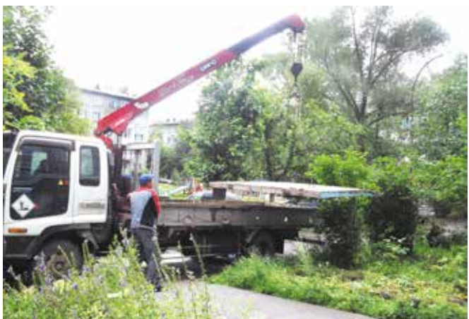
Автомобиль с краном-манипулятором транспортирует плиты для санустановки по ул. Блюхера, 8
